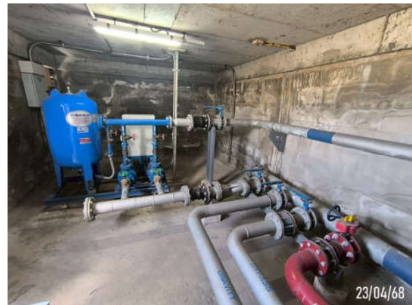
รูปที่ 2-14 Booster Pump
