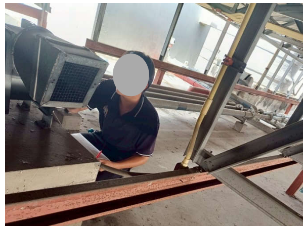
รูปที่ 2-48 การตรวจสอบพัดลมระบายอากาศ
