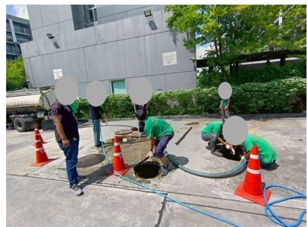
รูปที่ 2-10 เจ้าหน้าที่สูบล้างถังดักไขมันและกากตะกอนจาก ระบบบำบัดน้ำเสีย
