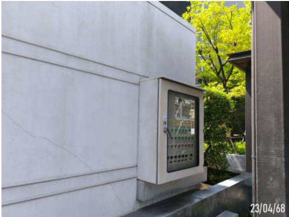
รูปที่ 2-11 ตู้ควบคุมระบบบำบัดน้ำเสียของโครงการ
